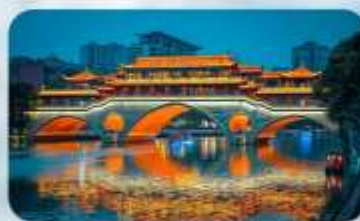
สะพานอันซุน
