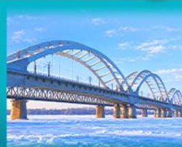
สะพานรถไฟป๋อโจว
